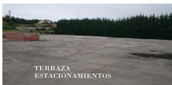
Acceso a Terraza estacionamientos. 24 plazas zona Sur y 53 más 6 motos zona Norte.
