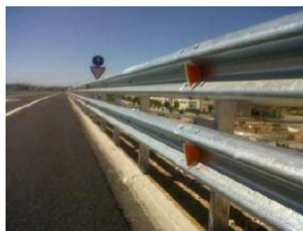
TD-2 Barrera de seguridad metálica
