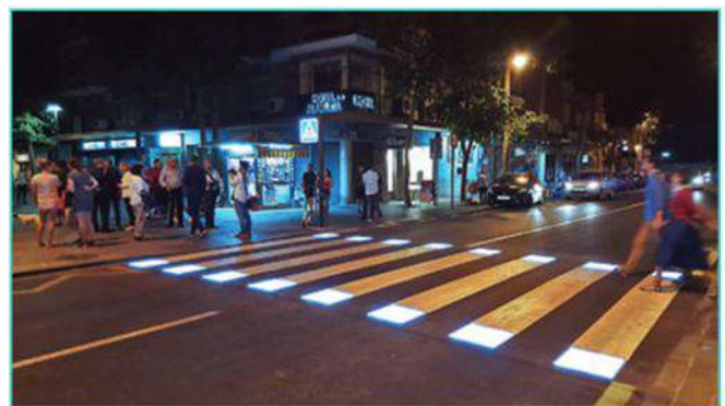
Marca vial de paso de peatones iluminada.
